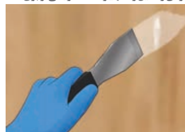
۴- صاف کردن هرگونه ترک از روی دیوار
