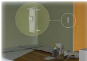
۲- قفل‌ها و دستگیره‌ها، کلیدها، پرزهای روی دیوار و سقف را حتی المقدور باز کنید.
