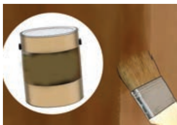
۵- آستر کردن دیوار با آستری (روغن الیف)
